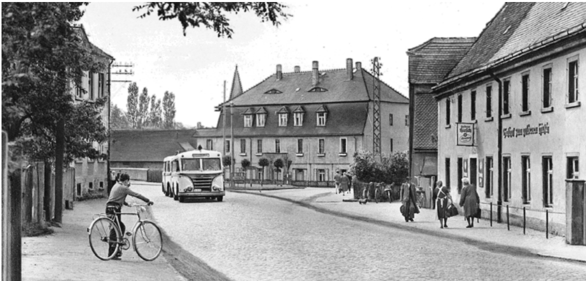
Abb. 32: Fernstraße F 6 Leipzig–Dresden Durch den Brückenbau über die Eisenbahn entstand später die heutige Kreuzung.
