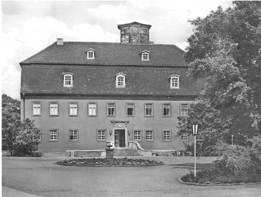
Abb. 29: Schloss mit teilweise abgerissenem Turm, 1948
