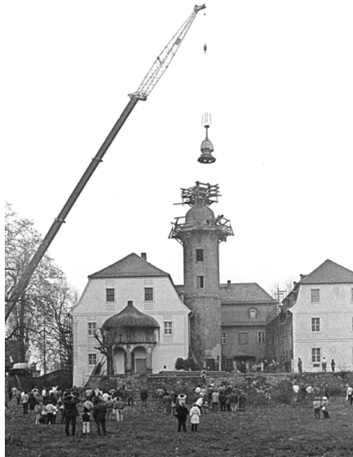
Abb. 39: Montage der Turmspitze
